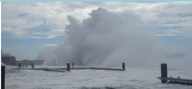
Danos nas estruturas portuárias
